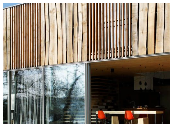
kontakt zasklení a dřevěného obkladu
