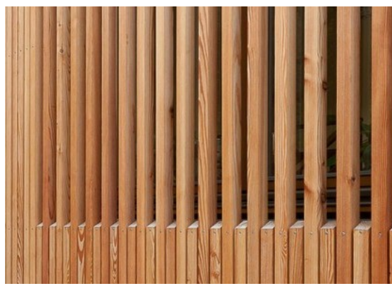
dřevěná laťová fasáda - detail okna
